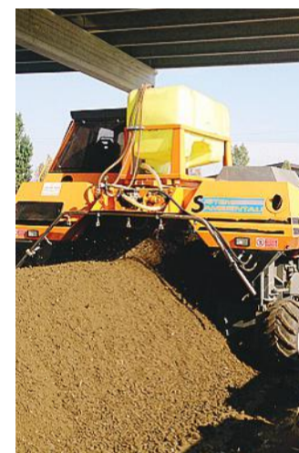
L'impianto che bonifica la terra
